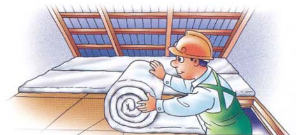
ติดตั้งฉนวนเหนือฝ้าเพดาน
